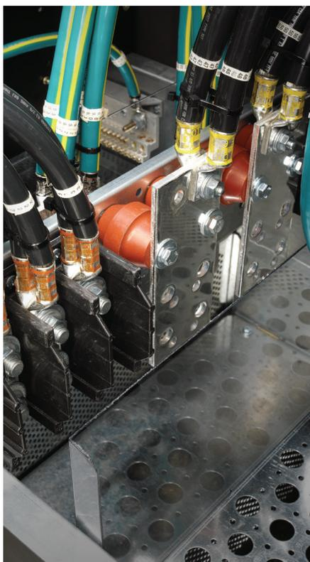
*Conexões de entrada de energia com provisão para bornes de 2 furos são padrão no Liebert FDC. (modelos mostrados 208V e 380-415V, 50 Hz).*
