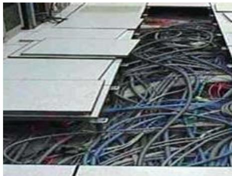
Data center tipico con cavi di alimentazione nel pavimento sopraelevato
