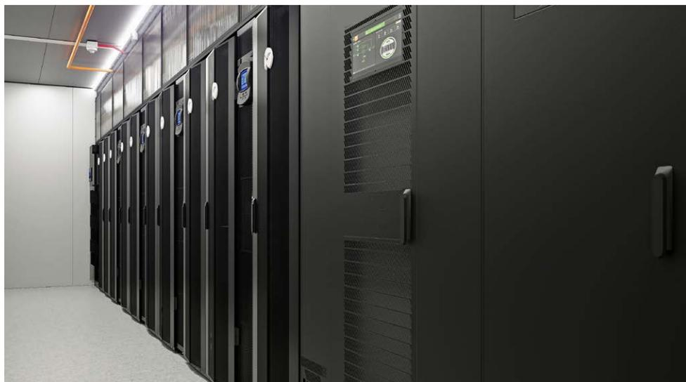
podría no necesitar UPS y un tercer UPS con una redundancia N+1. La evaluación de la viabilidad de un método de UPS basado en montaje en rack para hacer frente a necesidades específicas permitirá una redundancia distribuida a nivel de rack, lo cual elimina el sobre aprovisionamiento de capacidad de UPS y reduce potencialmente las necesidades de gastos de capital.
